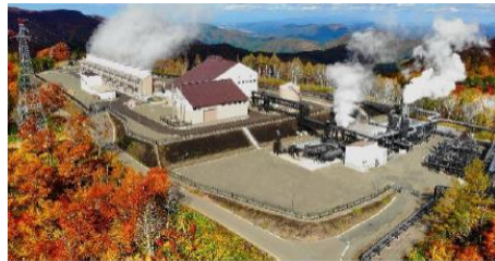
▲ 山葵沢地熱発電所
