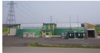
▲ バイオガスプラント
