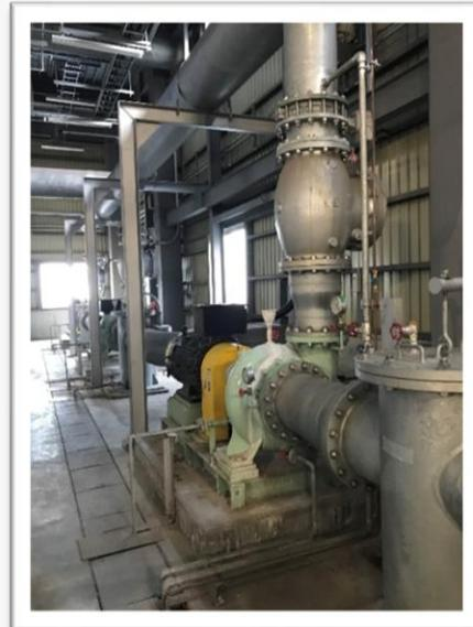
冬場は冷却水ポンプを一系統停止している
