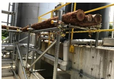
図-4-1-4.降雪による配管損傷防止策
