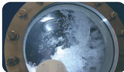
水車に設置された覗き窓
