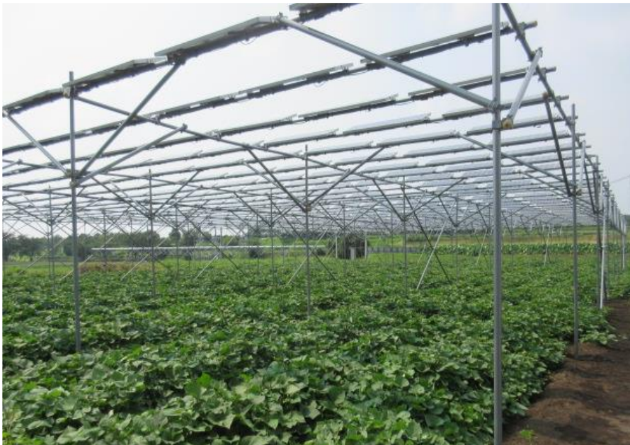
露地の畑の上部にパネルを設置
