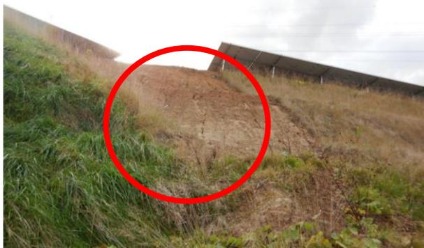
施工不備により土砂流出
