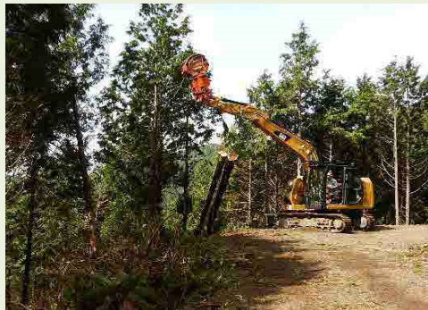
スイングヤーダによる集材（間伐）
