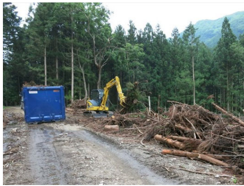
全木集材で発生し道路わきに集積され枝葉等を道路から回収
