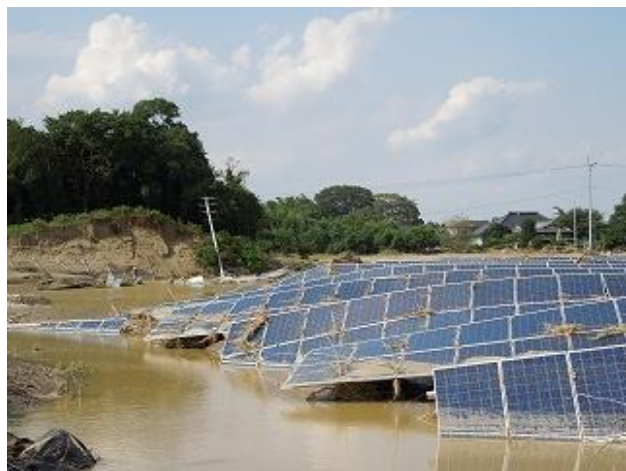
【参考】浸水・破損した太陽電池発電設備
