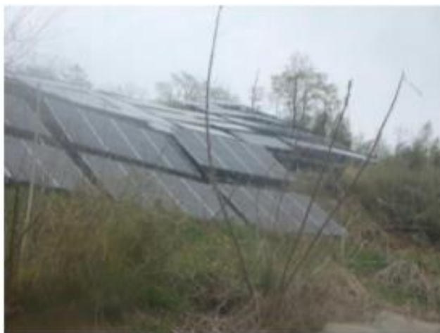
図 4-5 急傾斜地への設置
