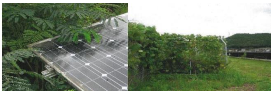
図 4-20 草木の成長による発電量低下、発電設備破損の事例
