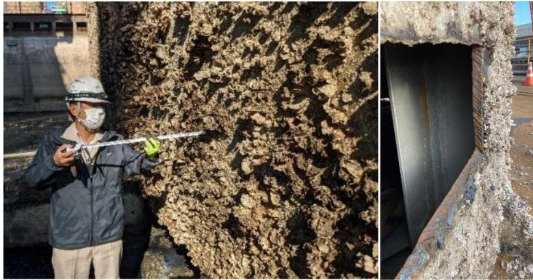
図10 浮体に付着した海洋付着生物の様子
