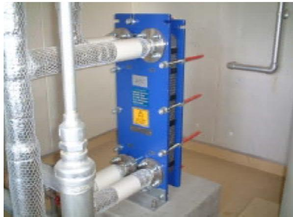
写真 3.5.1 プレート式熱交換器の例
