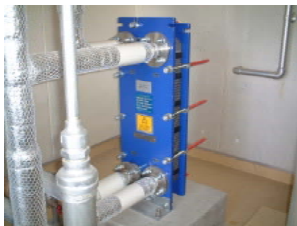
写真 3.5.1 プレート式熱交換器の例
