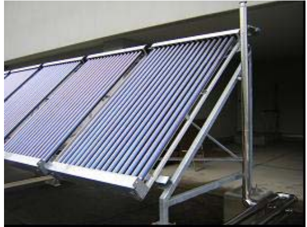
②真空ガラス管形集熱器 資料提供) 富士エネルギー(株)
