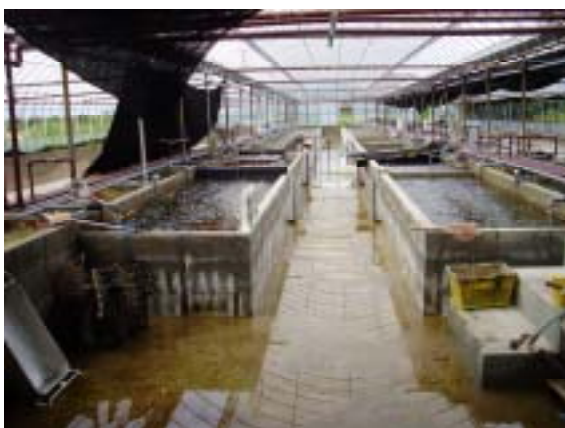
<養殖水槽設置状況>
