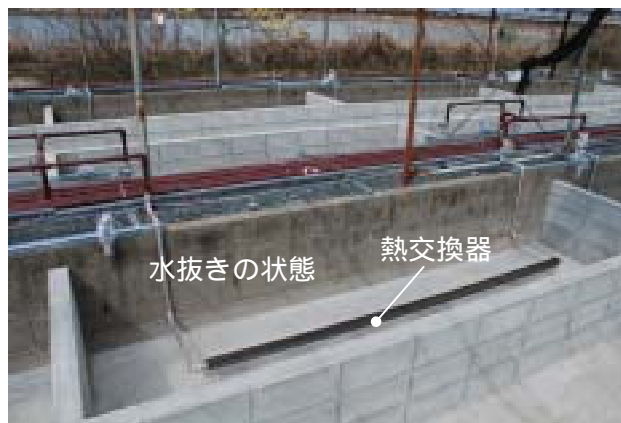
<養殖水槽内の熱交換器設置状況>
