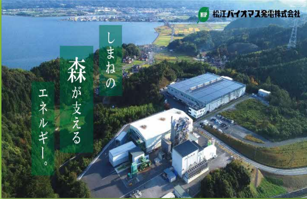
松江バイオマス発電所
