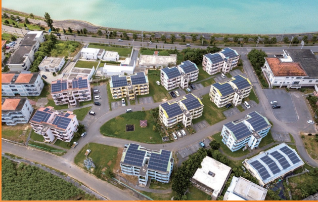
太陽光発電設備
