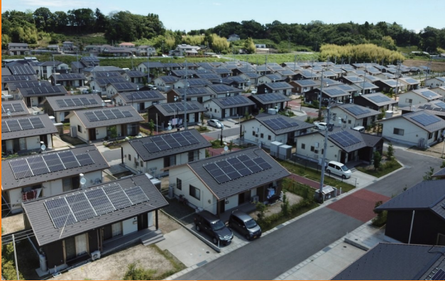
災害公営住宅屋根
