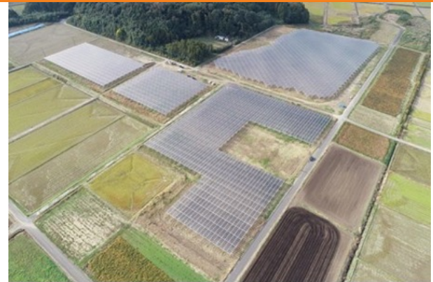
匝瑳おひさま発電所（2023年3月稼働、2.7MW）
