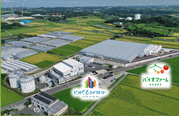
左：バイオガス発電施設（ピオぐるファクトリーHANDA） 右：植物工場（バイオファームHANDA）
