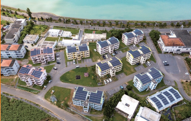
太陽光発電設備
