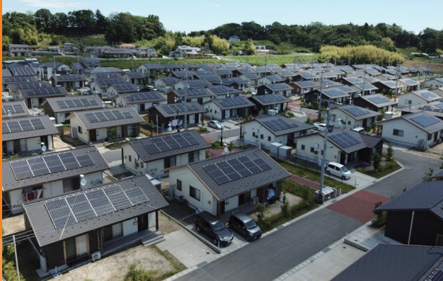
災害公営住宅屋根
