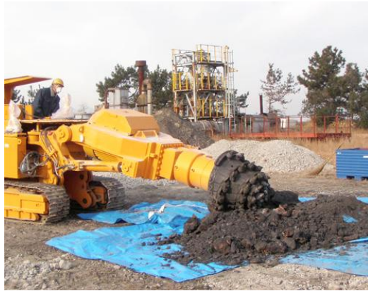
写真 6 掘削方法に関する陸上試験
