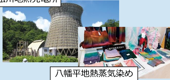
松川地熱発電所
