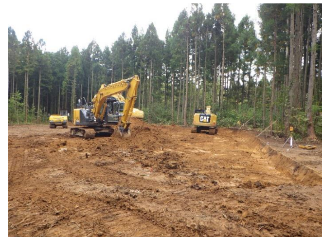
基地の敷地造成工事の状況
