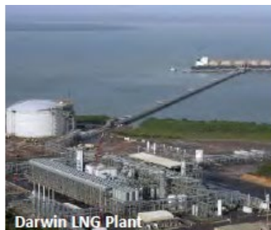
Darwin LNG Plant
