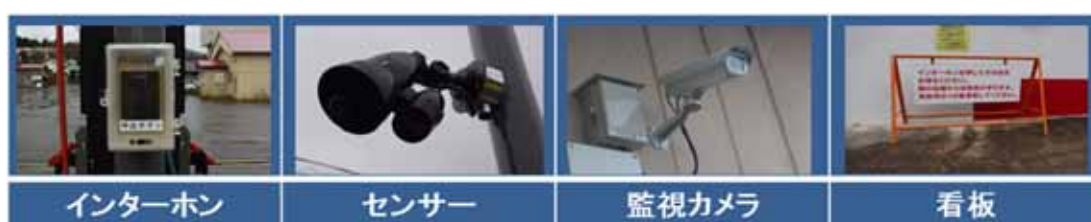
図2機器の設置状況
