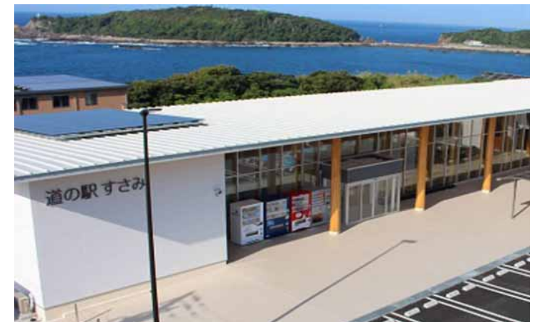
【隣接する道の駅すさみ】
