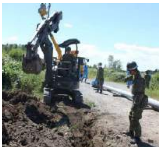
電柱建て込み場所の掘削作業
