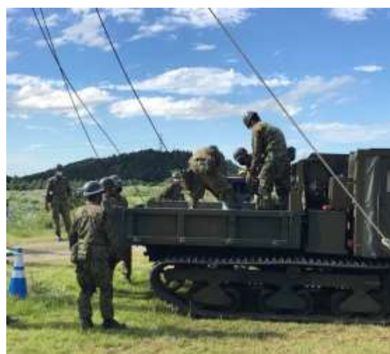
不整地運搬車による変圧器運搬
