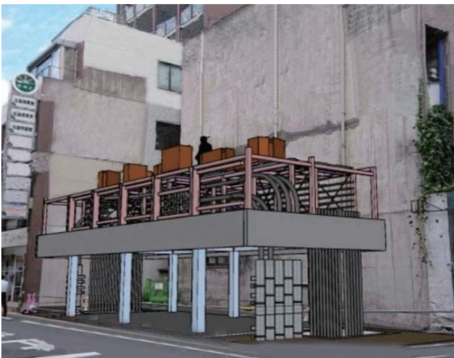
地上機器設置例(駐輪場)
