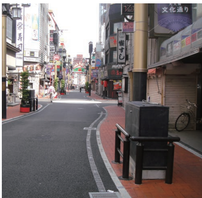
地上機器設置例(歩道部)
