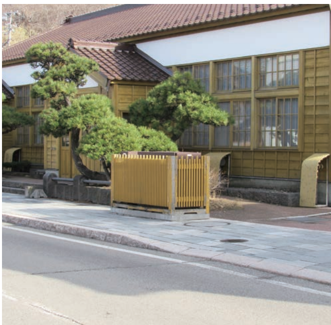
地上機器設置例(景觀配慮)
