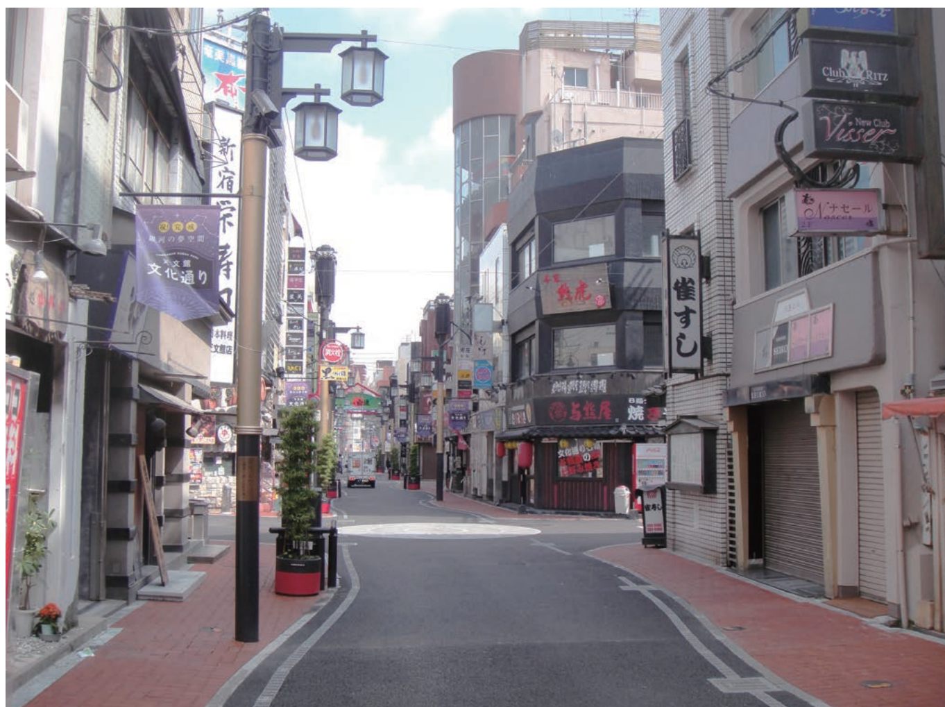
無電柱化整備写真
