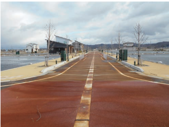
地上機器設置例
