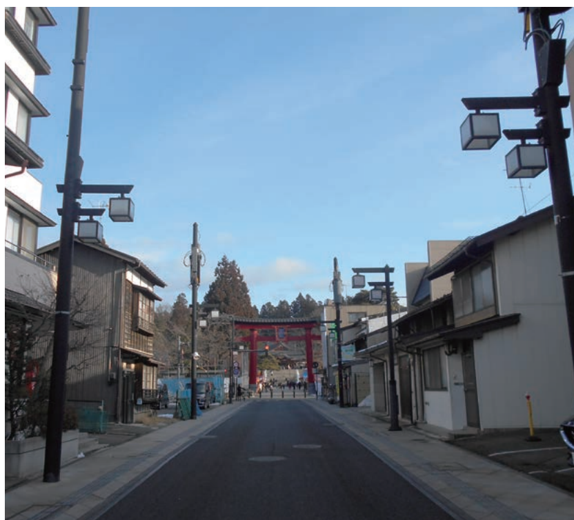
地上機器設置例(柱状型変圧器)
