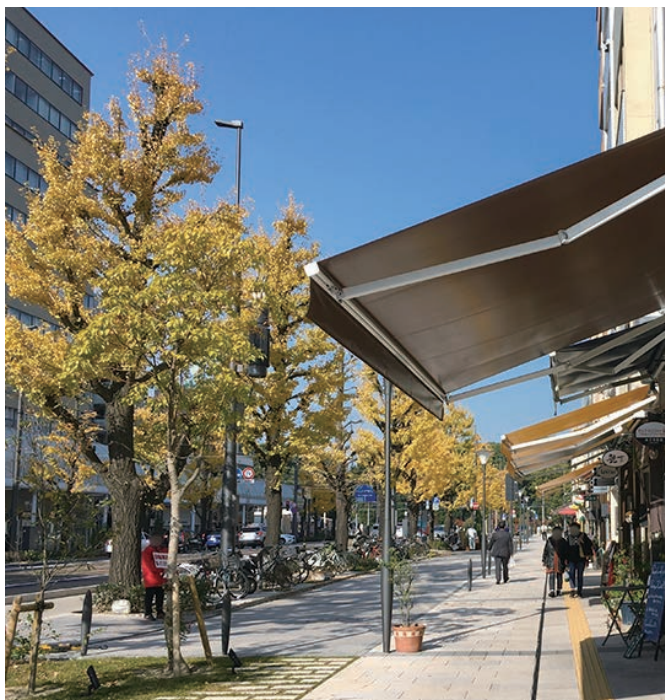
地上機器設置例(柱状型変圧器)
