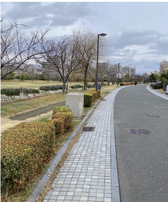
地上機器設置例(植樹帯)
