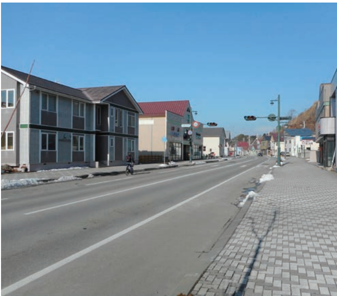
無電柱化整備写真
