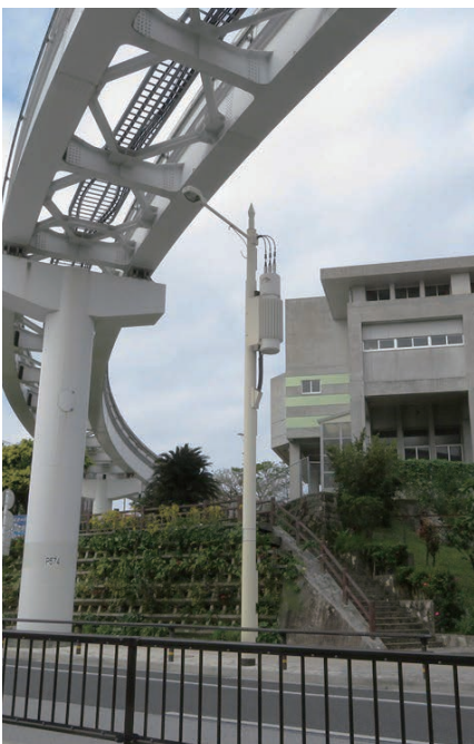
地上機器設置例(柱状型機器)
