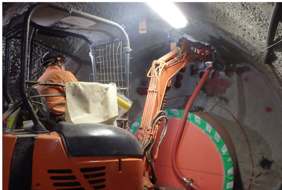
小型バックホウによる切削状況
