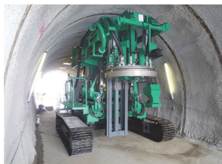
図 2.2-4 緩衝材除去システム（噴射・吸引設備の仕様）
