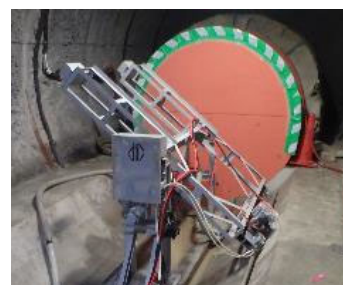
隙間充填材除去技術 WJ 方式
