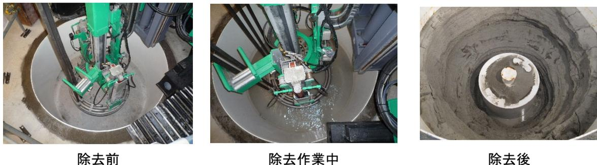
図 3.4-4 噴射吸引設備による緩衝材の除去
