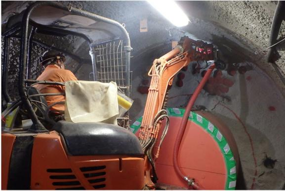
小型バックホウによる切削状況
