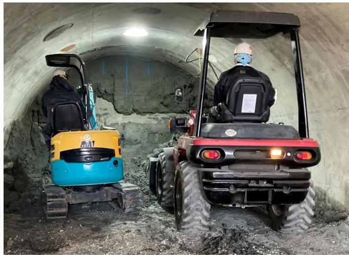
図 3.3-6 切羽における掘削装置と積込み装置
