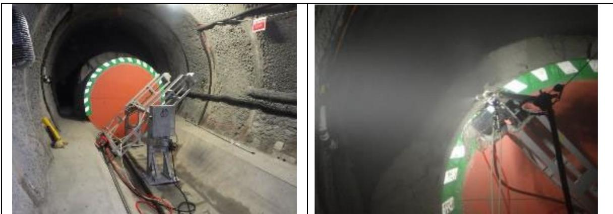
図 3.5-6 ウォータージェットによる PEM 周囲の隙間充填材の除去
