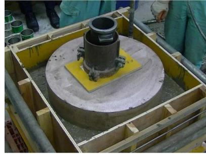
(d) 棒バイブレーターによる加振作業
