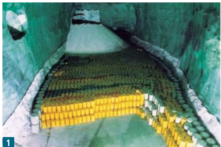
1 モルスレーベン処分場における廃棄物の定置風景 (DBE 社提供)
