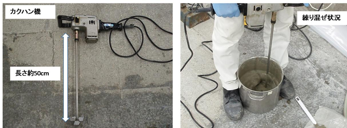
図 2.2-73 すき間充填材の練混ぜ
