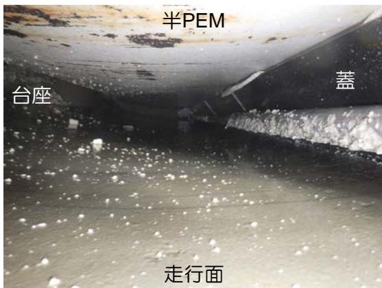
(e) 配管清掃用ノズル②による除去 (1 往復後)
