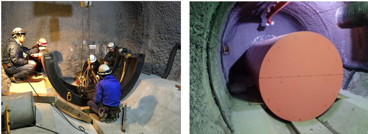
図 2.2.3-12 試験坑道 2 に定置した模擬 PEM[11]
