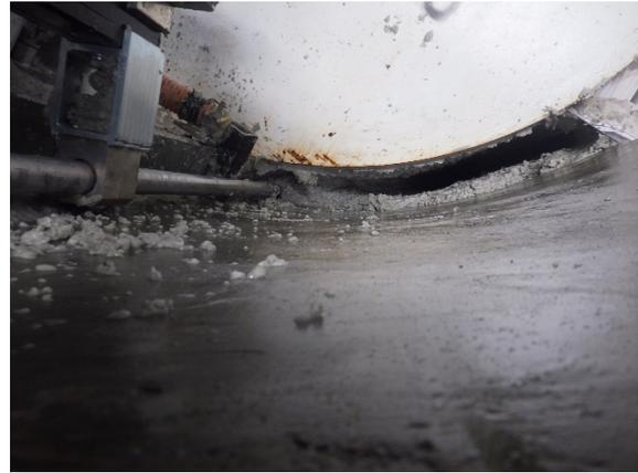
(d) 配管清掃用ノズル②による除去前
