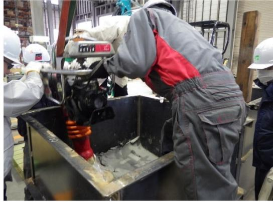
(b) ランマによる締固め
