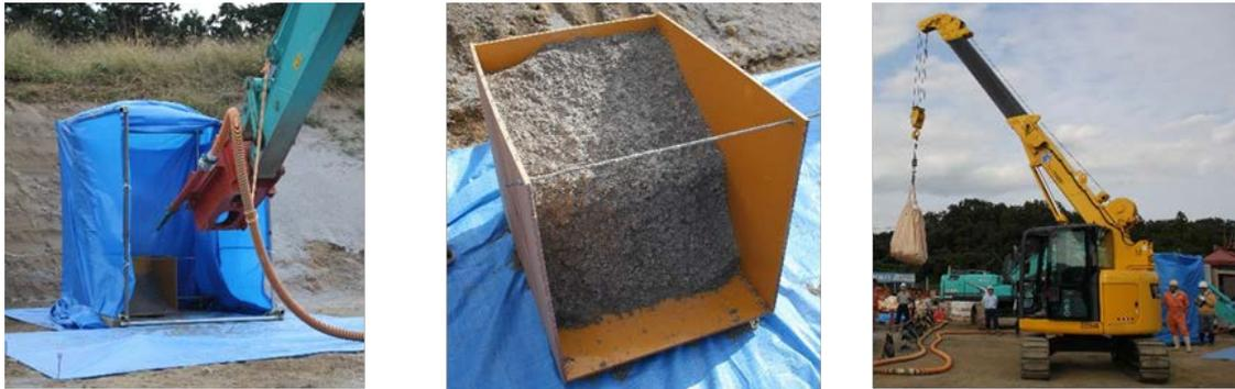
図 1.3.2-6 吹付け要素試験状況
