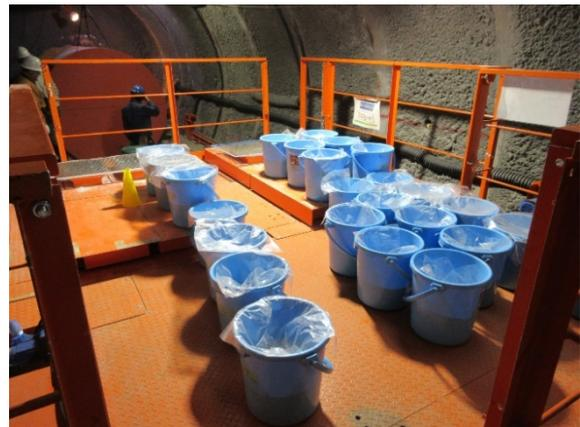
図 4.2.3-22 充填材料小分け作業完了
