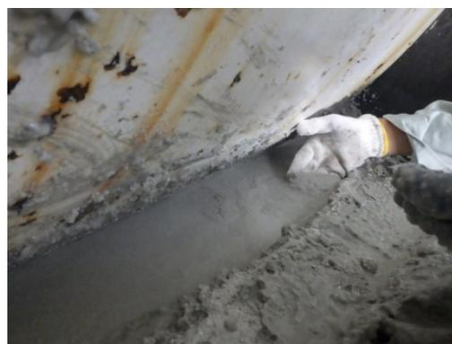
(b) トルネードノズルによる除去後、蓋を外し、隙間充填材の状態を確認
