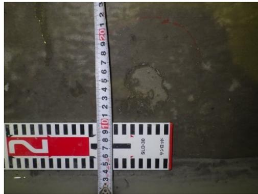
図 5.5.2-37 試験ケース 3-3 モルタルの剥がれ (5cm×7cm、深さ 2～3mm)
