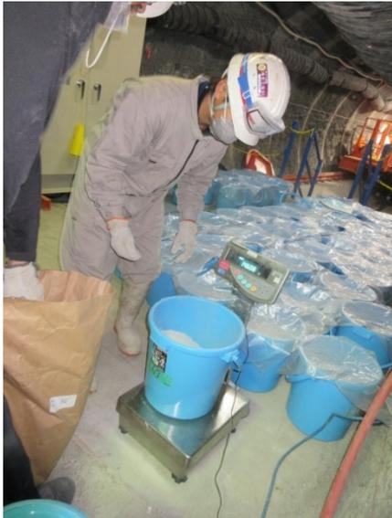
図 4.2.3-19 充填材料小分け作業
