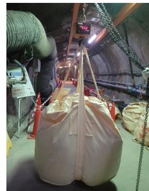
長距離空気搬送機（ジェクター）によるリバウンド捕集、クレーンスケールでの計量
