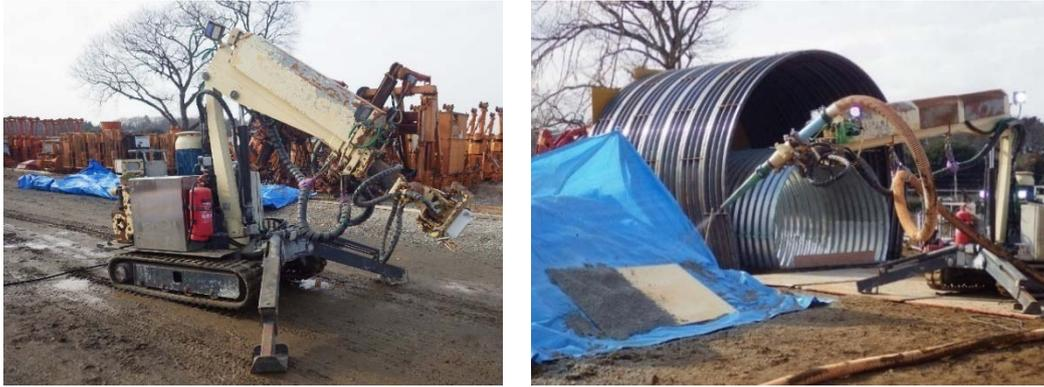
図 1.3.2-7 伸縮アームを有する吹付け装置を使用した吹付け施工確認試験の状況
