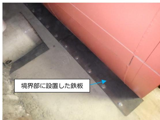
図 4.3.3-1 下部狭隘部と上部開放部の境界に設置した鉄板
