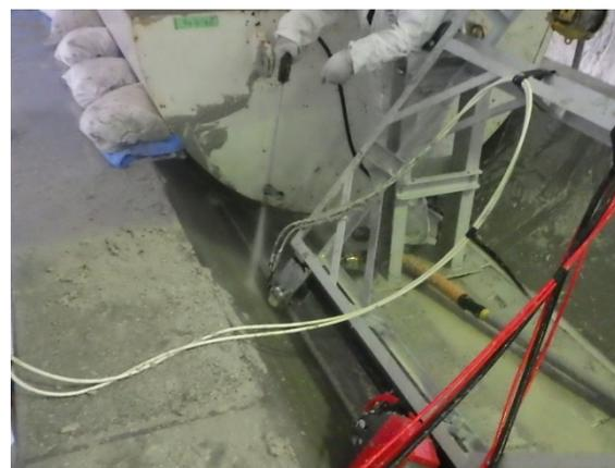
図 5.5.2-44 ハイウォッシャーによる回収補助
