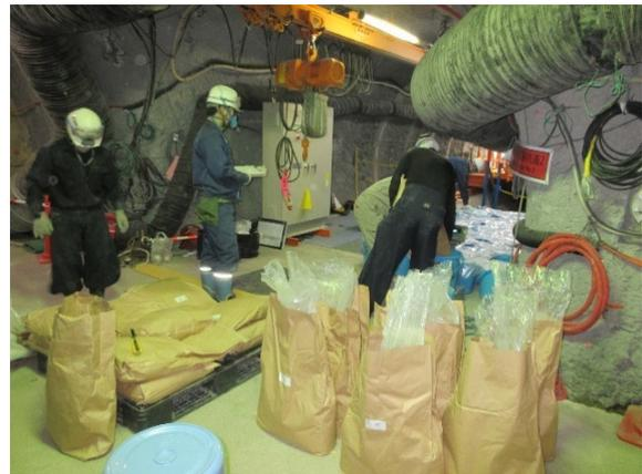
図 4.2.3-20 充填材料小分け作業全景
