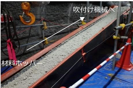
材料ホッパーから吹付け機械への材料供給
