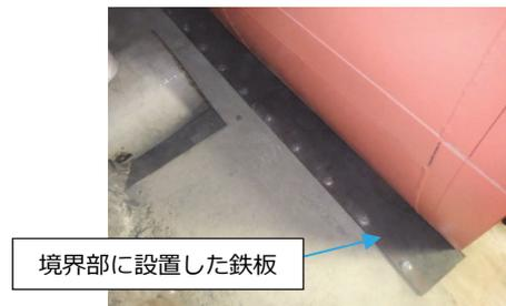
図 2.3.3-2 下部狭隘部と上部開放部の境界に設置した鉄板
