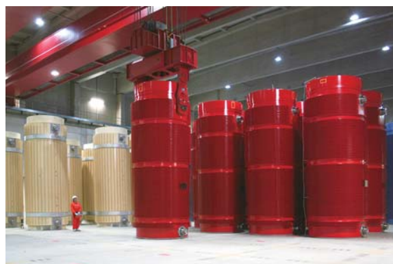
ゴアレーベン中間貯蔵施設における使用済燃料の乾式中間貯蔵 (写真提供：GNS社)
