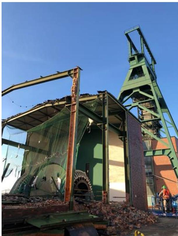
図 8.2-3 古いホイスト建屋と古いケーペ式ホイストシステム(Koepe hoisting system)の解体
