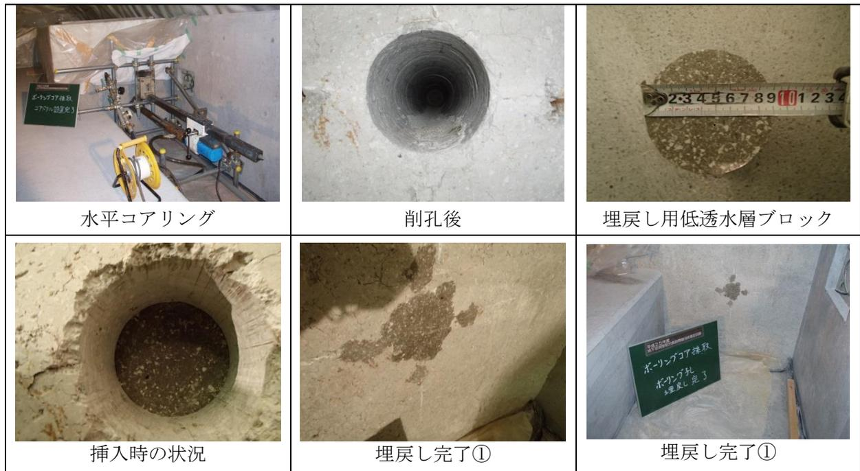
図 4.7-14 側部緩衝材の水平掘削と埋戻し補修例
