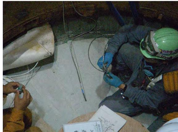
計測センサーの設置状況（光学式pH計の例）
