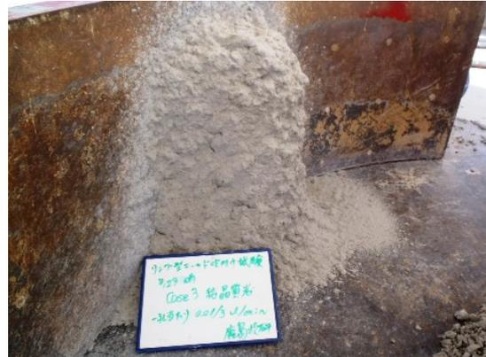
図 9.4.2-24 吹付け後の施工部 (Case3)
