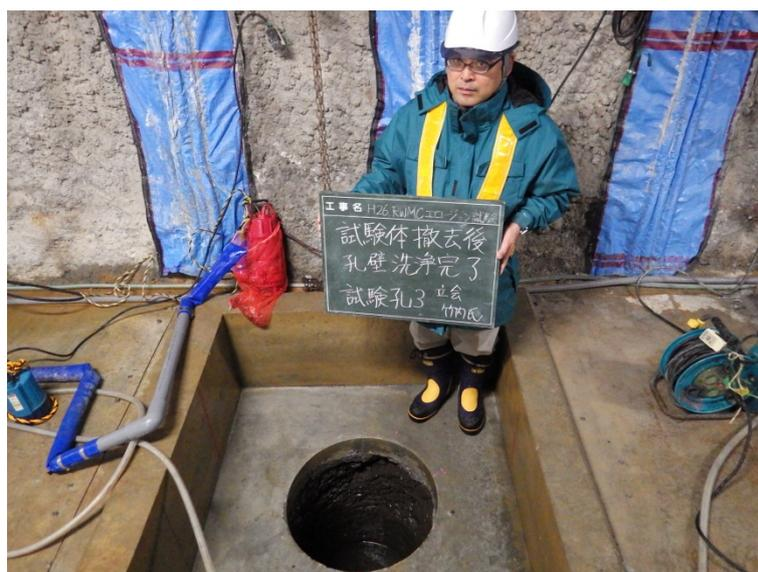
図 10.11.4-4 孔壁洗浄完了（試験孔 3）
