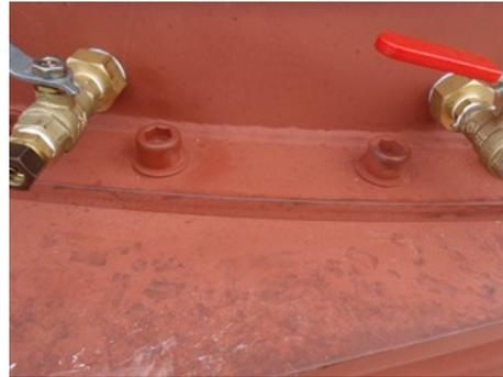
図 9.4.3-9 底板と側壁の剛結箇所
