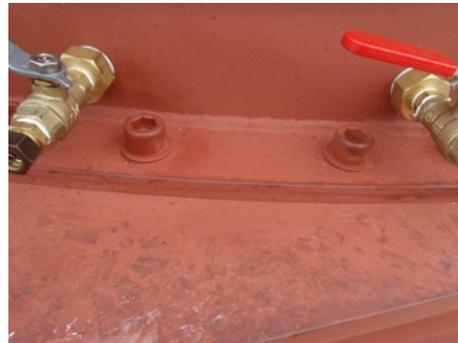
図 9.2.1-3 底板と側壁の剛結箇所
