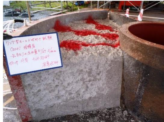
図 9.4.2-12 吹付け後の施工部 (Case1)
