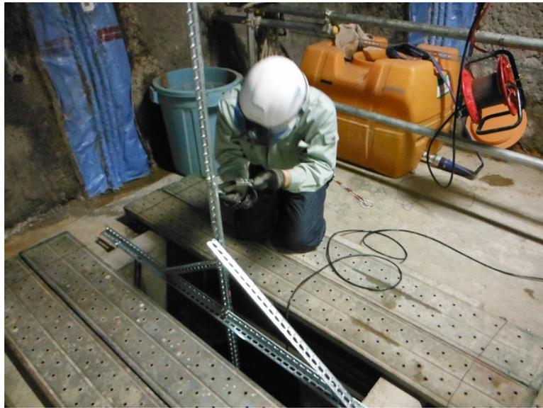
図 10.7.2-2 流向流速センサ取り付け治具設置状況
