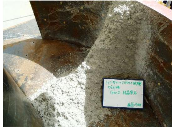
図 9.4.2-19 吹付け後の施工部 (Case2)
