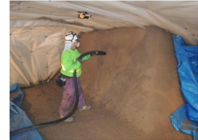
図2.5-5 吹付け工法による施工状況
