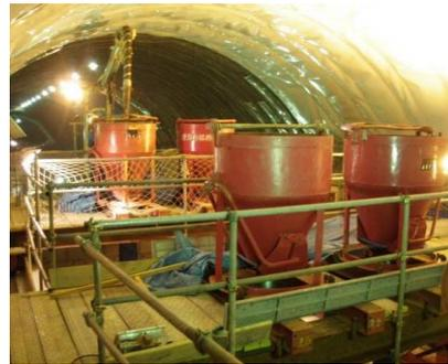
図2.4-1 移動式バケット方式
