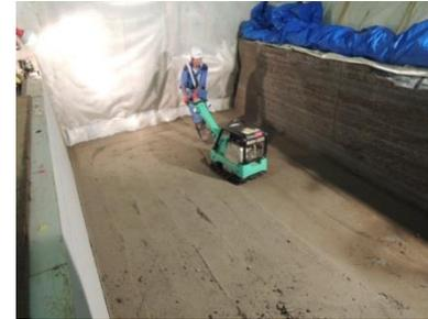
図2.5-4 転圧工法による施工状況
