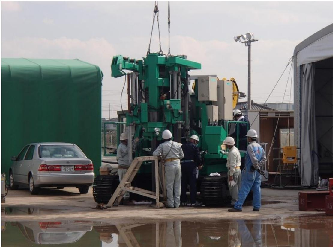
図 4.2.3-4 昇降装置組立状況 2
