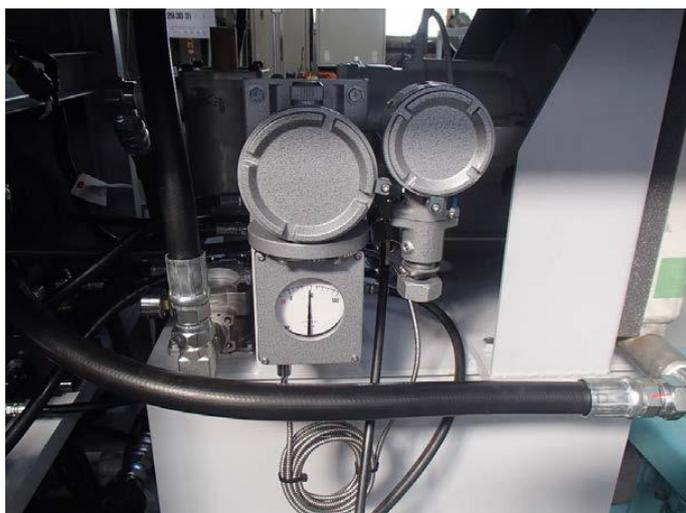
図 3.1.3-13 【油圧ユニット部】 作動油タンクおよび油温計設置状況
