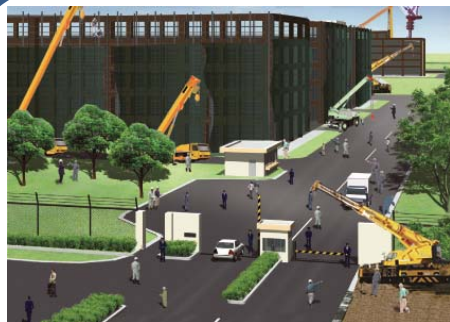
建設中のイメージ
