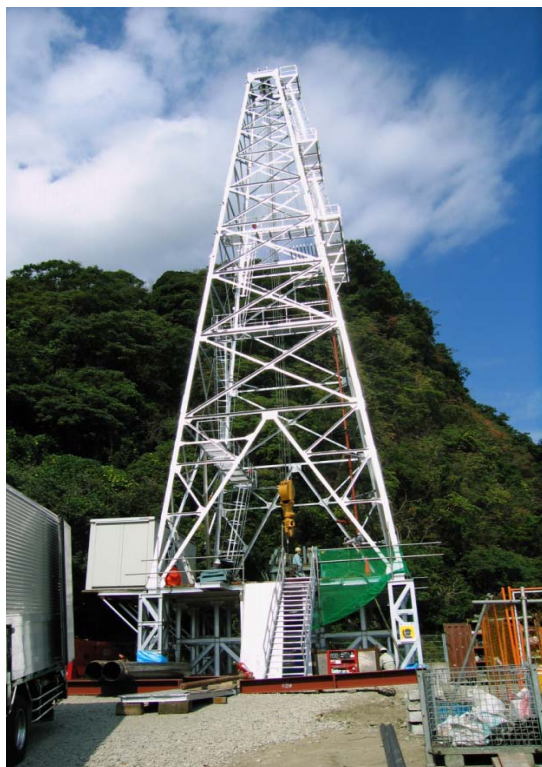
ボーリング調査の外観(やぐら)
