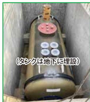
電源車の燃料を蓄える貯蔵タンクを設置
