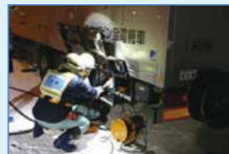
電源喪失時を想定し電源ケーブルを接続する訓練
