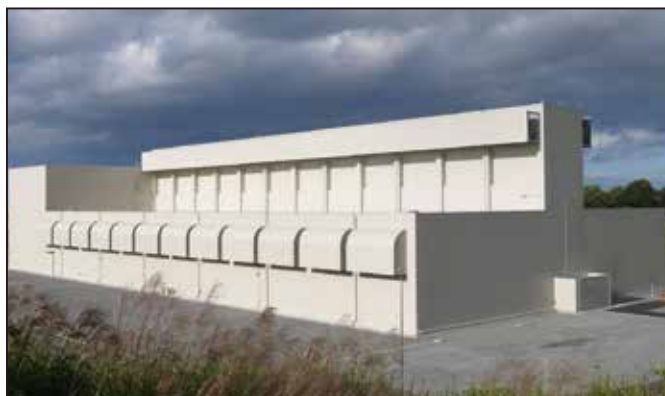
貯蔵建屋外観
