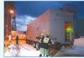
電源喪失時を想定し 電源ケーブルを敷設する訓練
