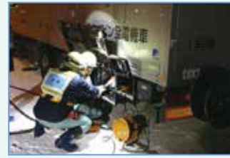
電源喪失時を想定し 電源ケーブルを接続する訓練
