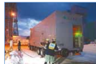
電源喪失時を想定し 電源ケーブルを敷設する訓練
