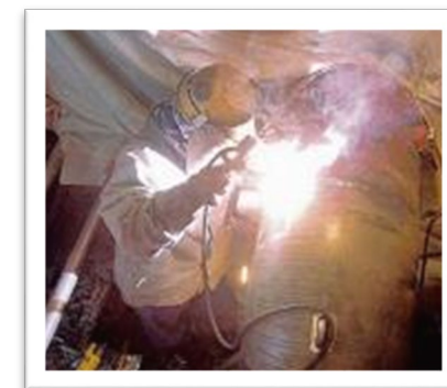
配管の取替え
