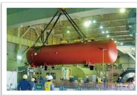
高圧給水加熱器の取替え
