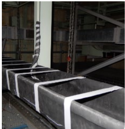
<防火シート施工箇所>
