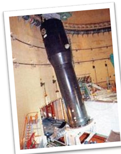
蒸気発生器の取替え
