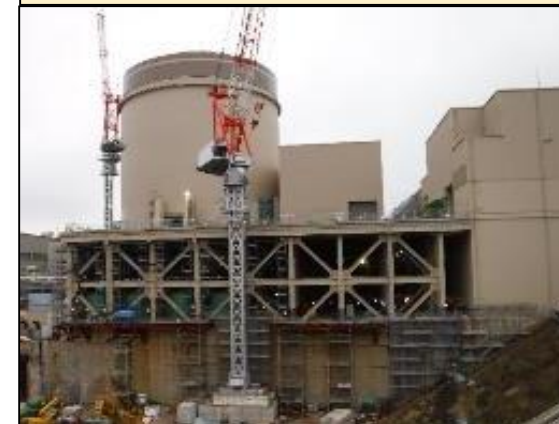
構台設置状況(2020.2)
