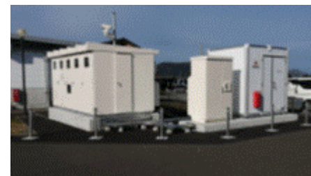
〔蓄電池（原子力事業本部）〕
