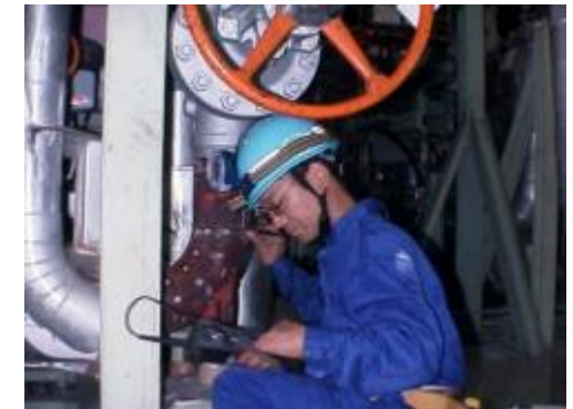
配管の厚み点検
