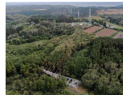
鉄塔設備の倒壊（君津市）
