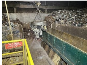
クリアランス金属の吊り上げ
