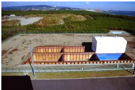
埋設実地試験場
