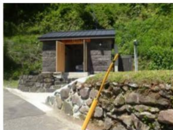
地域の石を使った発電所建屋
