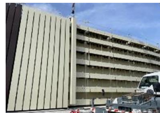
防潮堤かさ上げ工事
