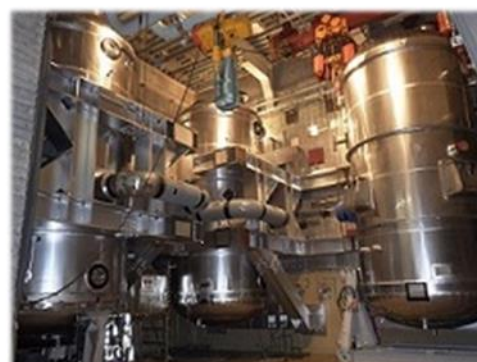
フィルタベント系設置工事
