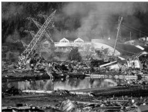
〔傾斜した鉄塔〕
