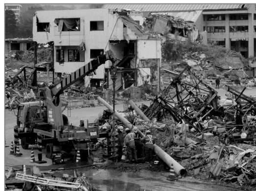
〔津波被災地での建柱作業〕
