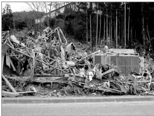
〔志津川変電所〕
