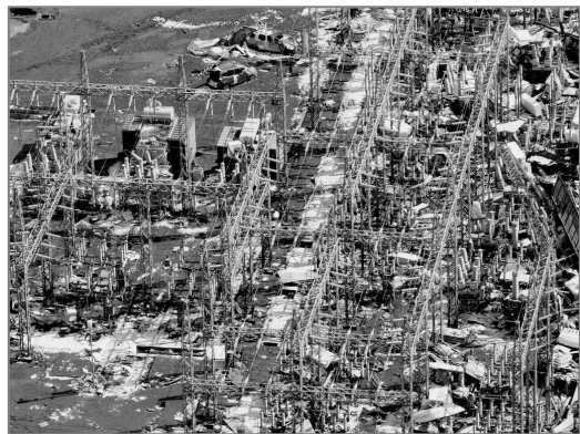
〔多賀城変電所〕
