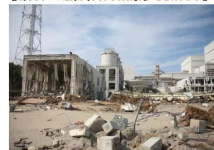
【原町火力発電所】
