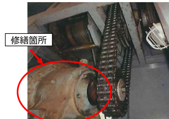
取水口除塵機部分修繕（駆動装置）
