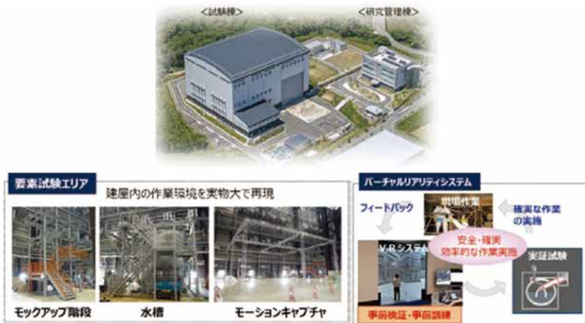
【第111-4-3】モックアップ設備を有する櫛葉遠隔技術開発センターと試験設備
